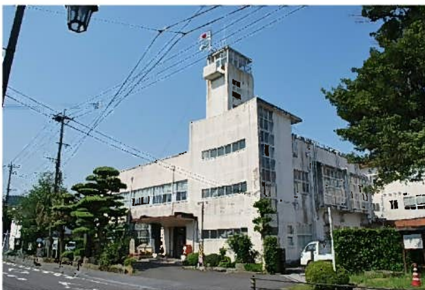
図 2-3 蒲生庁舎本館（昭和 29 年築）
