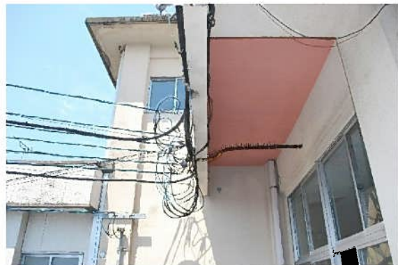
図 2-18 外壁に露出した配管（始良庁舎）
