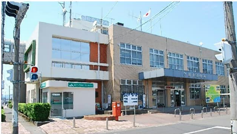
図 2-2 始良庁舎本館（昭和 35 年築）
