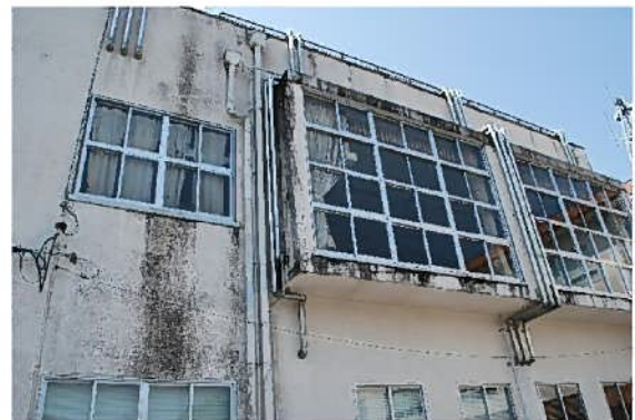
図 2-20 外壁に露出した配管（蒲生庁舎）
