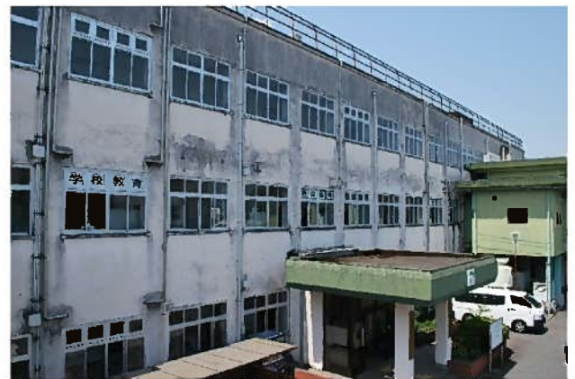
図 2-4 加治木庁舎南庁舎(昭和 35 年築)
