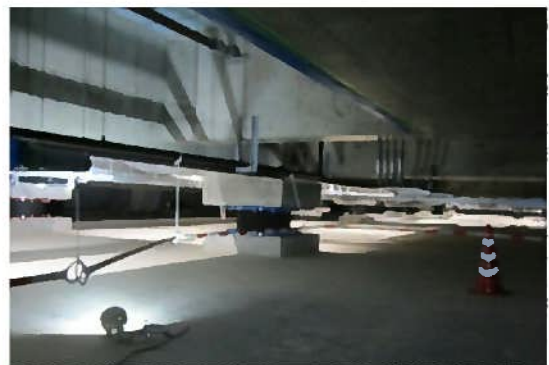
図 7-5 免震層と免震装置の例
