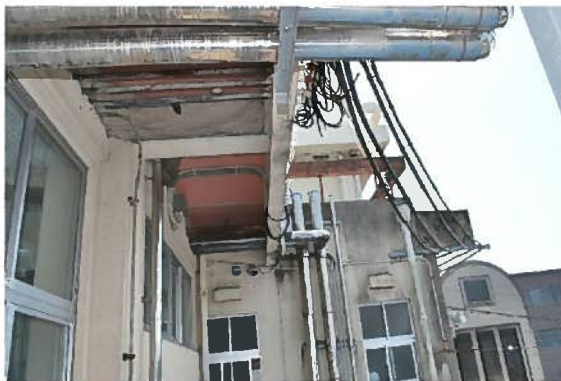
図 2-17 外壁に露出した配管（始良庁舎）
