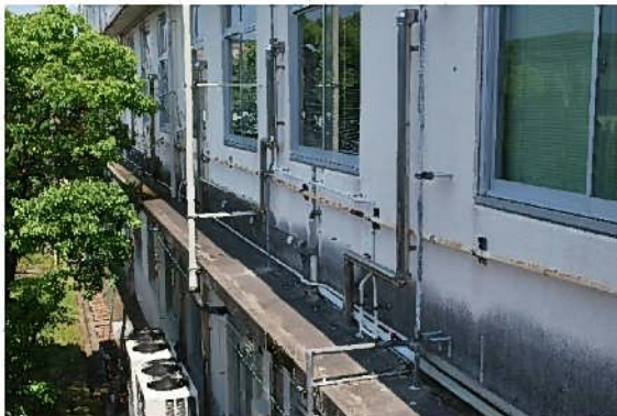
図 2-19 外壁に露出した配管（加治木庁舎）
