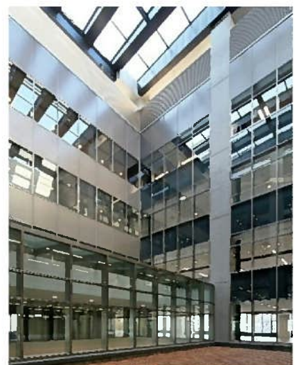
図 2-49 吹き抜けにより自然採光・自然換気を行う庁舎のイメージ
