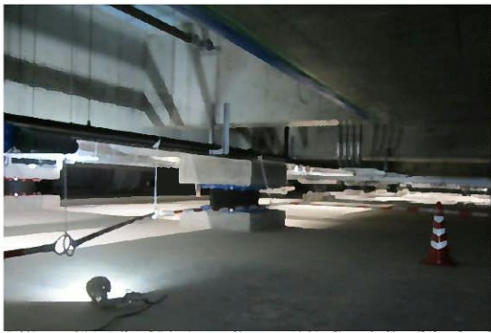
図 13 免震層と免震装置の例
