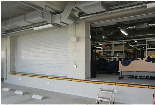
図 12 生活支援物資等の備蓄倉庫の例
