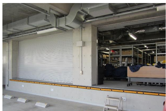
図 14 生活支援物資等の備蓄倉庫の例
