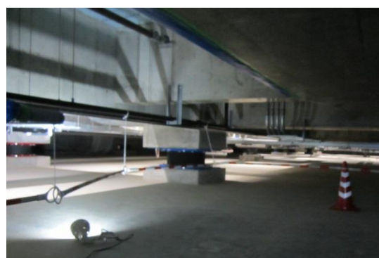
図 15 免震層と免震装置の例
