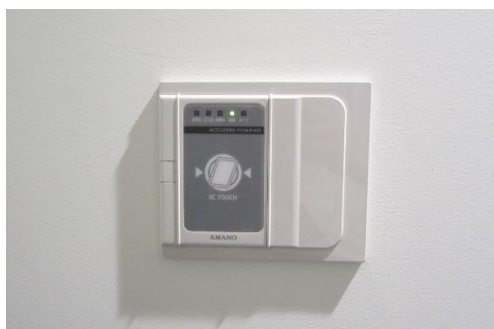
図 33 ＩＣカードや手のひら認証による入退室管理の例
