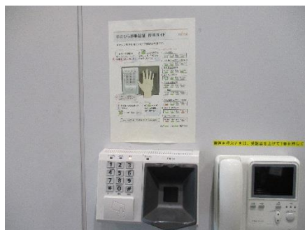
図 33 ＩＣカードや手のひら認証による入退室管理の例
