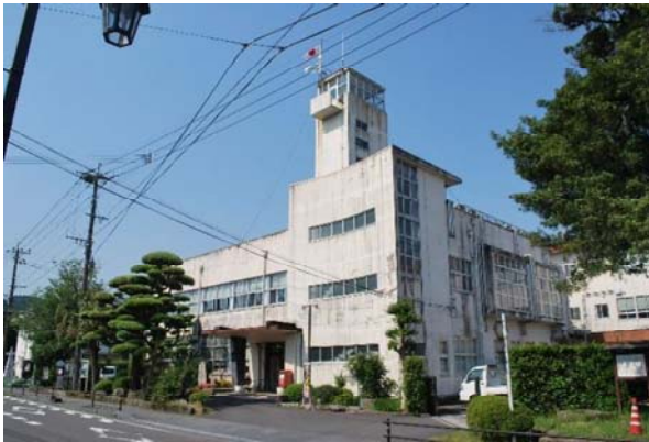
図 2-3 蒲生庁舎本館（昭和 29 年度築）
