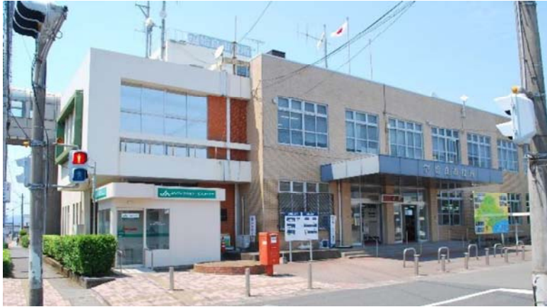
図 2-2 始良庁舎本館（昭和 35 年度築）
