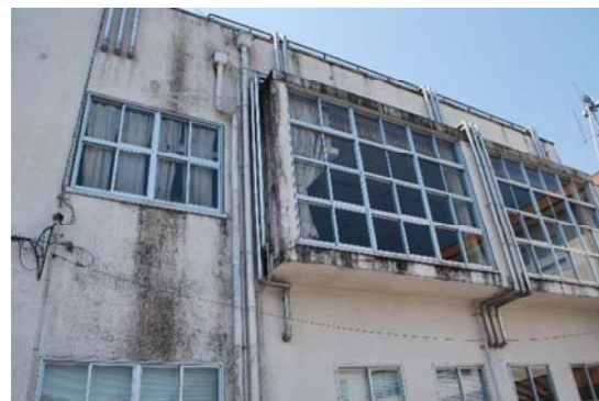
図 2-20 外壁に露出した配管（蒲生庁舎）
