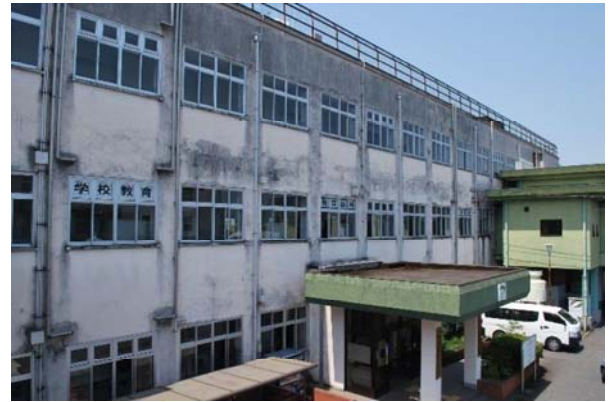
図 2-4 加治木庁舎南庁舎（昭和 35 年度築）
