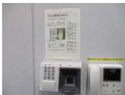
図 7-29 ＩＣカードや手のひら認証による入退室管理の例
