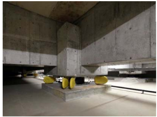
図 2-39 耐震性能の高い免震構造庁舎のイメージ 図 2-40 免震装置のイメージ
