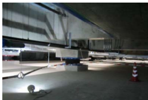
図 7-5 免震層と免震装置の例
