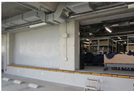
図 7-4 生活支援物資等の備蓄倉庫の例
