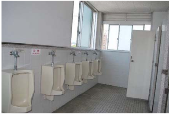
図 2-25 旧型の衛生器具（始良庁舎）
