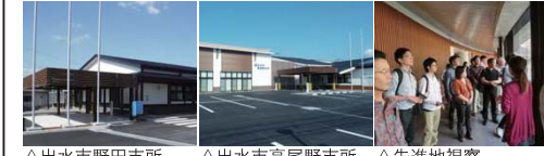
△出水市野田支所
