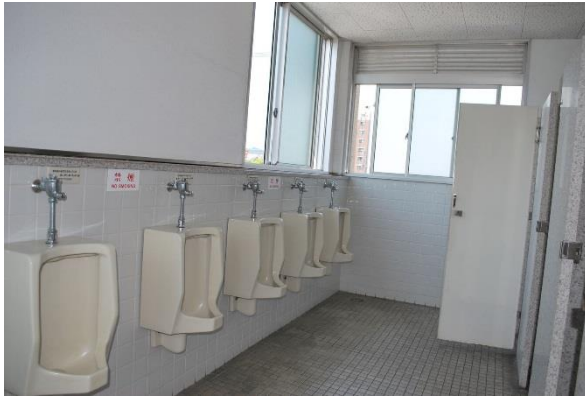
図 2-25 旧型の衛生器具（始良庁舎）
