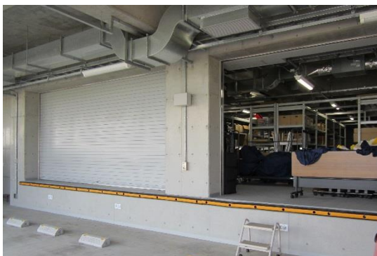
図 7-4 生活支援物資等の備蓄倉庫の例
