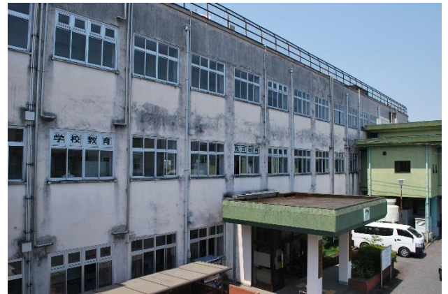
図 2-4 加治木庁舎南庁舎（昭和 35 年度築）
