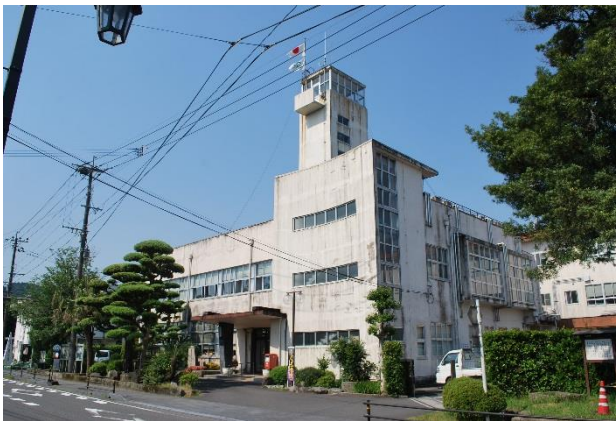
図 2-3 蒲生庁舎本館（昭和 29 年度築）
