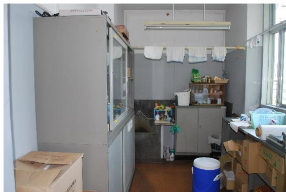
図 2-24 手洗い場（加治木庁舎）
