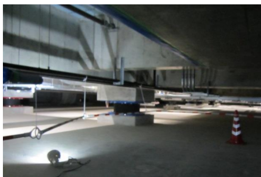
図 7-5 免震層と免震装置の例
