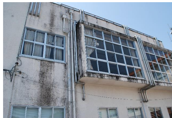
図 2-20 外壁に露出した配管（蒲生庁舎）
