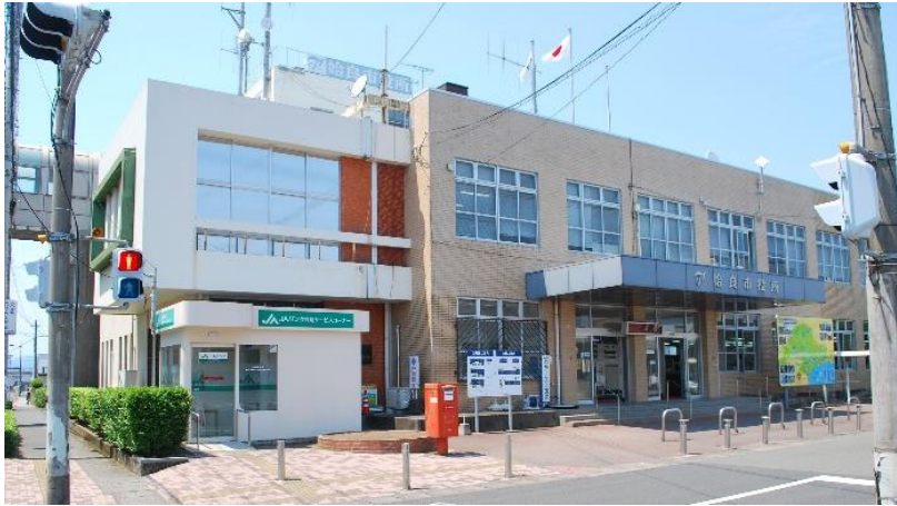
図 2-2 始良庁舎本館（昭和 35 年度築）
