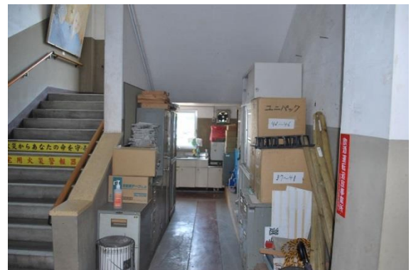
図 38 階段に置かれた書棚等（加治木庁舎）
