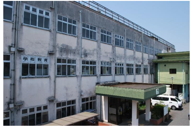
図3 加治木庁舎南庁舎（昭和35年築）
