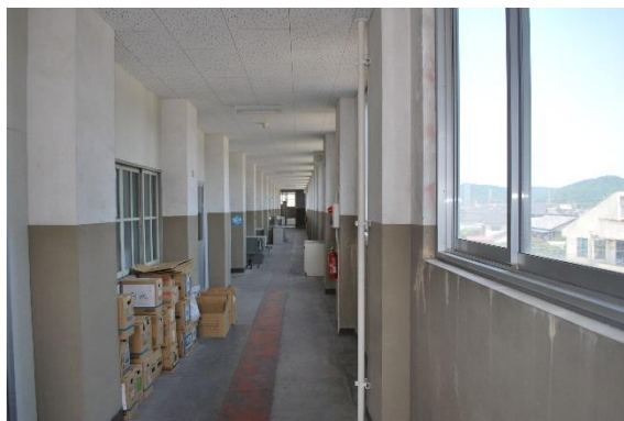
図 41 使用されていない部屋が並ぶ3階 (加治木庁舎)
