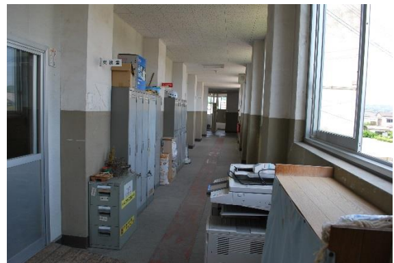
図 34 廊下に置かれたプリンター （加治木庁舎）
