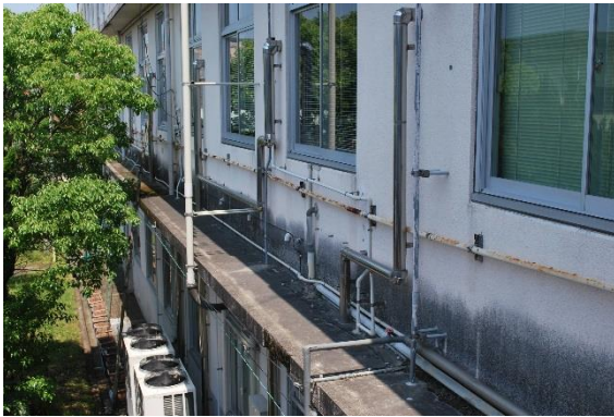
図 18 外壁に露出した配管（加治木庁舎）
