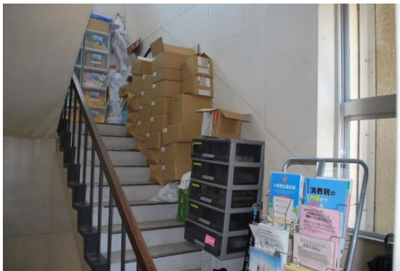
図 37 階段に置かれた事務用品等 (始良庁舎)
