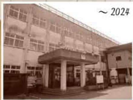
加治木中学校が現在の場所に移転後、昭和57(1982)年から旧校舎を庁舎として活用してきました。
