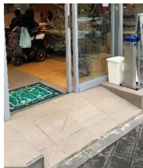
スロープの設置
