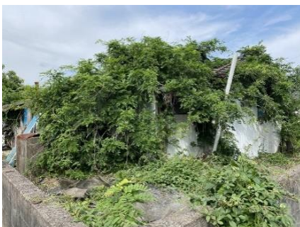
雑草が繁茂した空き家
