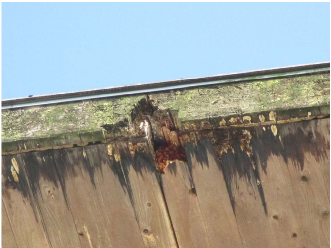
南側屋根ひさし先端部分 腐食状況
