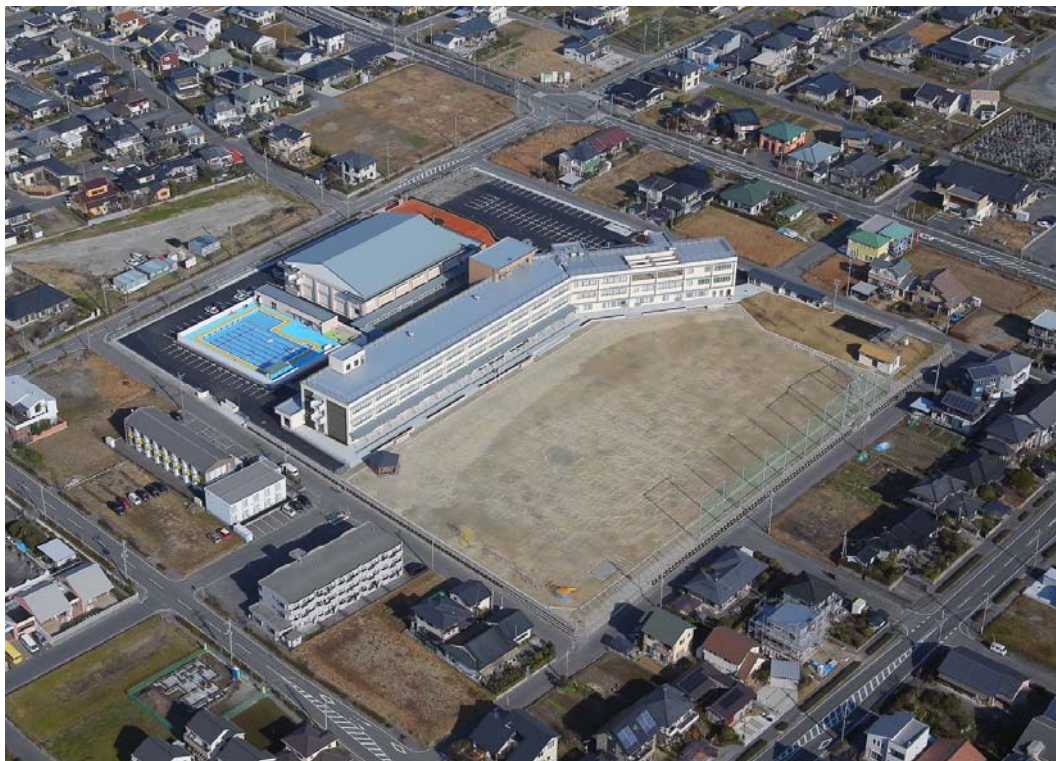
(平成 27 年 1 月 23 日撮影 工事進捗率 99.0%)
