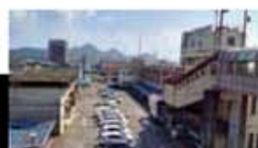
解体する始良庁舎本館など
