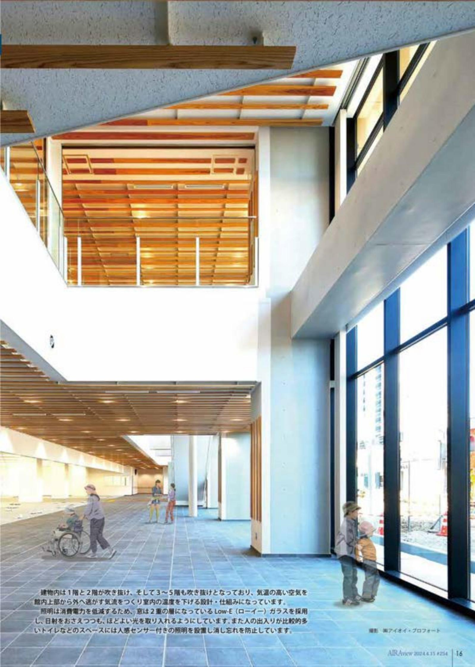
建物内は1階と2階が吹き抜け、そして3～5階も吹き抜けとなっており、気温の高い空気を館内上部から外へ逃がす気流をつくり室内の温度を下げる設計・仕組みになっています。
