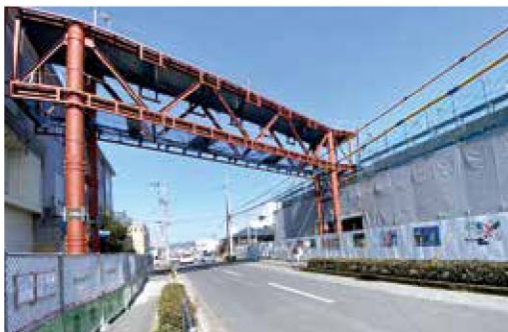
骨組みが完成した渡り廊下
