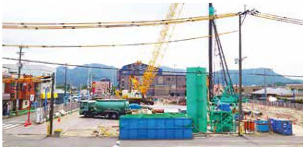
基礎(杭)工事をすすめている始良庁舎本館建設敷地。画像中央奥は2号館。現場事務所から撮影。R4.5.12時点
