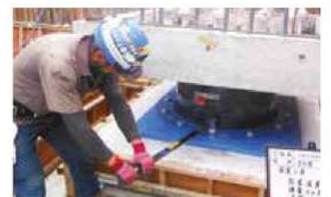
免震装置「支承」の取付作業の様子。ゴムの「もとの形に戻る」性質を利用し、地震の激しい揺れを減衰させる。
