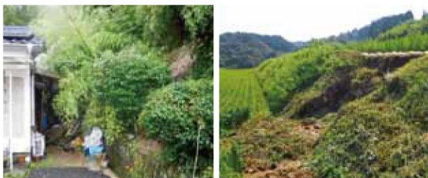
豪雨・台風災害により建物に接する法面が崩壊した加治木の竜門小教頭住宅(左)や、あぜが崩れ水田などに被害が及んだ(右・野中地区)。
