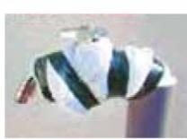
写真のように蛇口部分に布類(タオルや古着など)を巻き、ビニールテープで固定する。タオルの外側にビニール袋をかぶせると、より効果があります。
