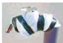
写真のように蛇口部分に布類（タオルや古着など）を巻き、ビニールテープで固定する。タオルの外側にビニール袋をかぶせると、より効果があります。※タオルは濡らさないようご注意ください。
