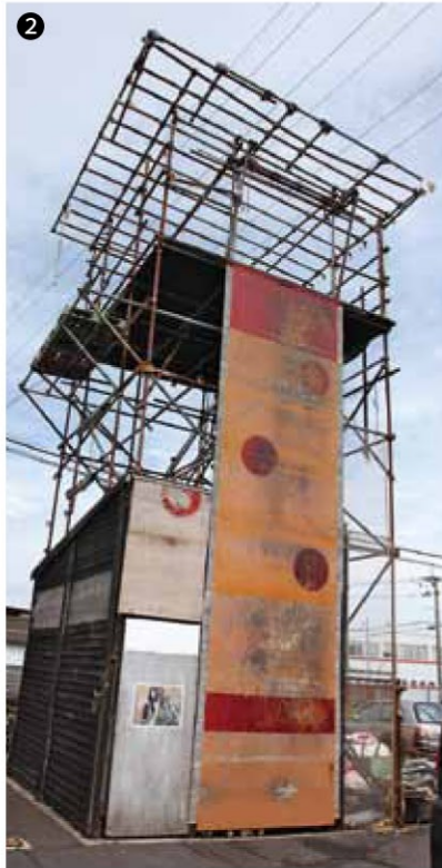
①新庁舎建設に向け、9月から解体工事がはじまる現消防庁舎。大型化する消防車両には対応しておらず、将来的な導入が検討されているはしご車のような背の高い車両は格納できない。 ②鉄パイプで組み立てられた中央消防署の簡易式訓練塔。雨風や日々の訓練でサビなどの傷みが酷い。
