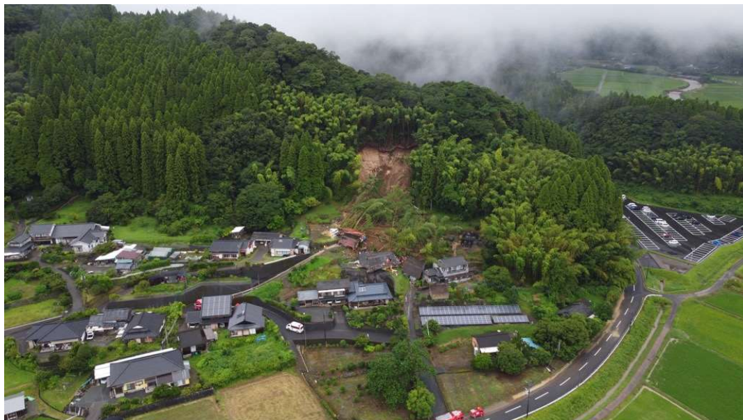
【蒲生地区土砂崩れ地点】
