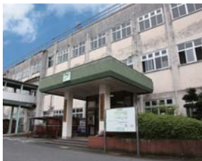
加治木庁舎の南庁舎
