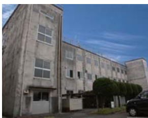
加治木庁舎の北庁舎
