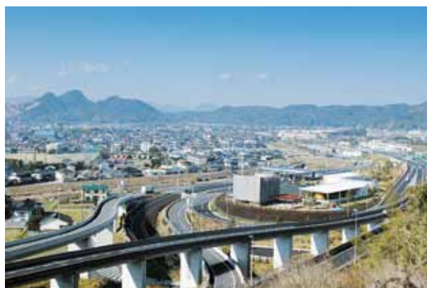
加治木インターチェンジ
