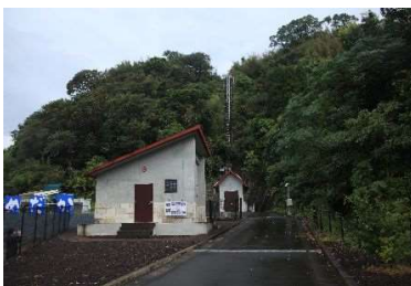
龍門滝発電所 (150kW) 2015 (平成 27) 年設置
