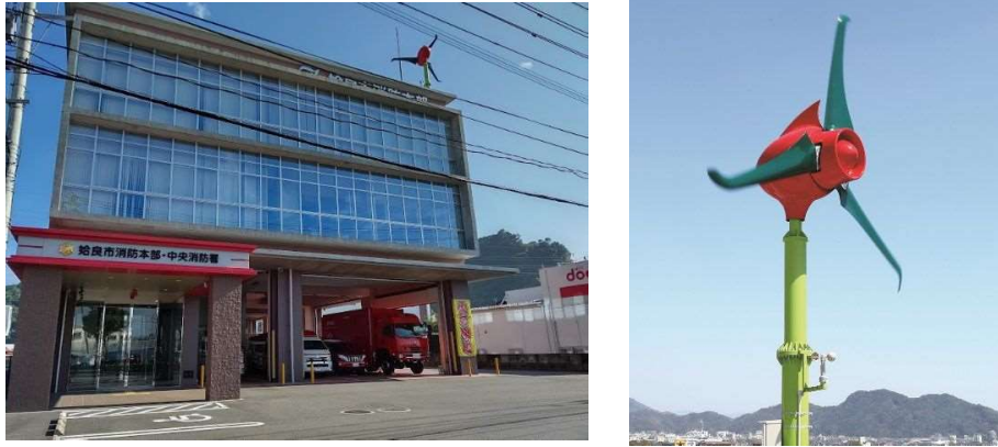
図 37 始良市消防本部庁舎の小型風力発電機
