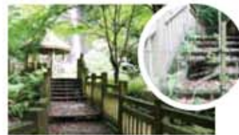
撤去予定の木製歩道
