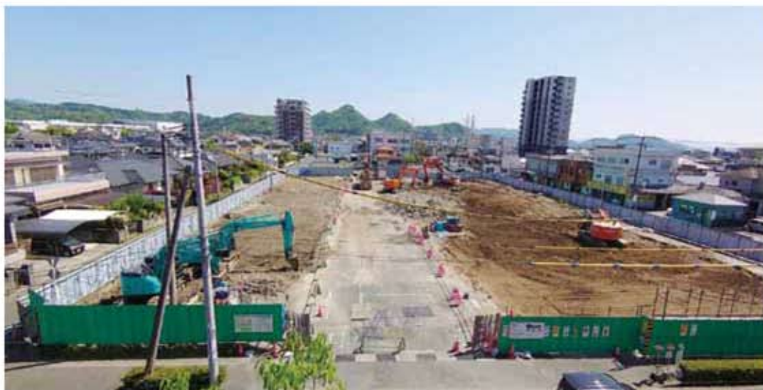
解体工事が進み、ほぼ更地となった旧始良庁舎本館敷地(今年4月撮影)と解体前の様子(下/今年1月)
