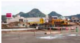
建設中のイオンタウン
