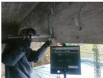
補修状況(ひび割れ注入)
