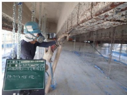
補修状況(断面修復)
