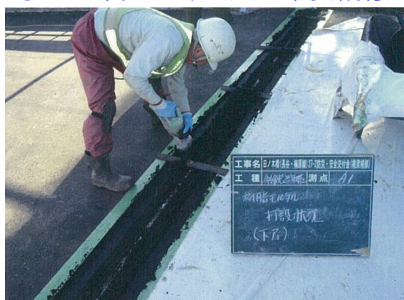
補修後(伸縮装置取替え)
