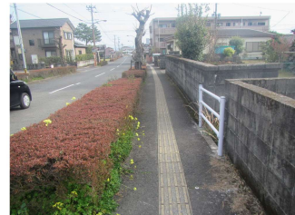
③歩道沿いに水路があり 転落する危険
