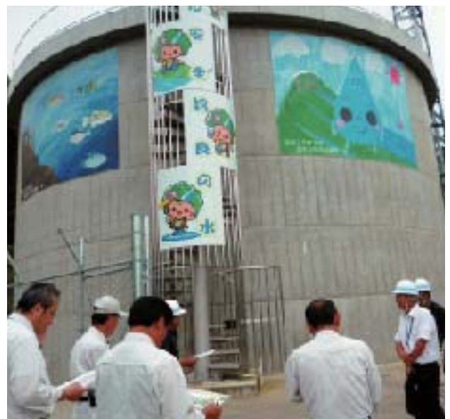
▲完成した中迫配水池の本体
