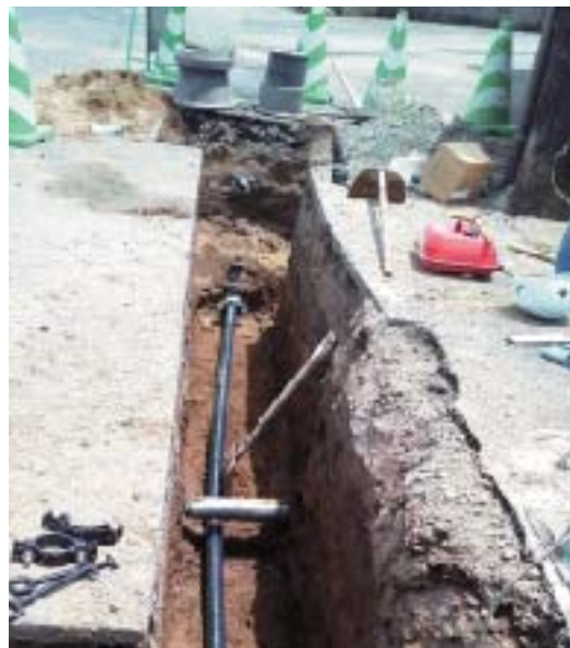
▲布設替え工事（加治木町新生町）
