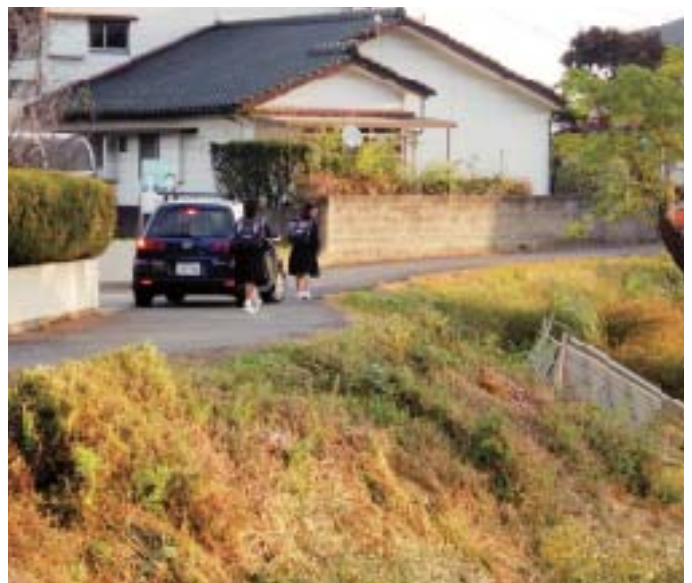
▲道路幅が狭くガードレールもない危険な道路
