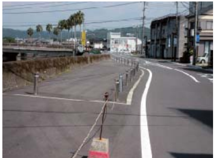
▲駐車スペースとして開放が望まれる堤防沿い
