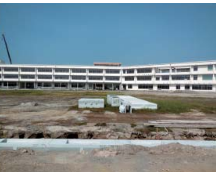
▲平成27年4月に開校する松原なぎさ小学校
