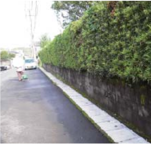
▲整備された側溝ぶた
