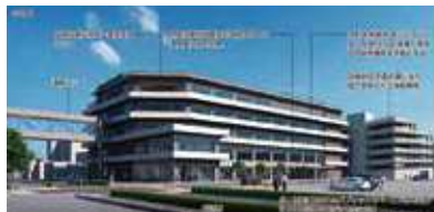
当初の立体駐車場（5層6段）から平面駐車場に変更
