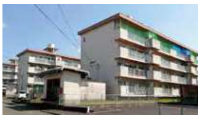
風呂釜なしの市営住宅
