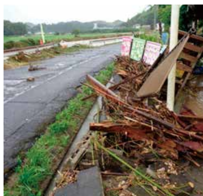
水害を受けた小山田保育所
