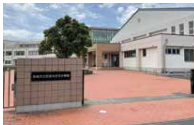
オール地元業者で建築された松原なぎさ小学校
