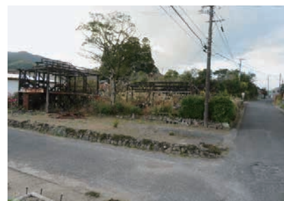
移住直前に火災に見舞われ放置状態の現場
