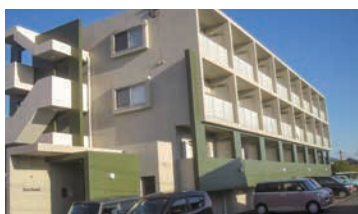
共同住宅が完成し交通量も増え道路整備が必要
