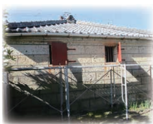
解体中の石蔵
