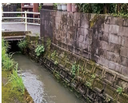
毎年あふれる支線用水路(松原上)
