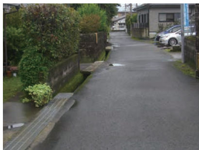
側溝整備が完了すれば安全に離合可能となる道路
