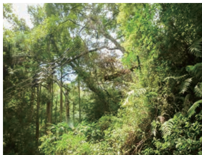
倒木による電線を切断した場所(林道柵野宇都線)
