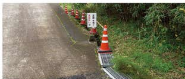
▲蒲生町後田地区周辺の排水路
