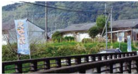
▲用途廃止になった高井田住宅
