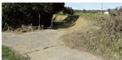
▲整備が望まれる狭い農道
