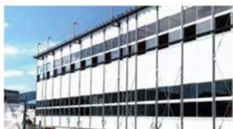
▲図書館横プレハブ仮庁舎
