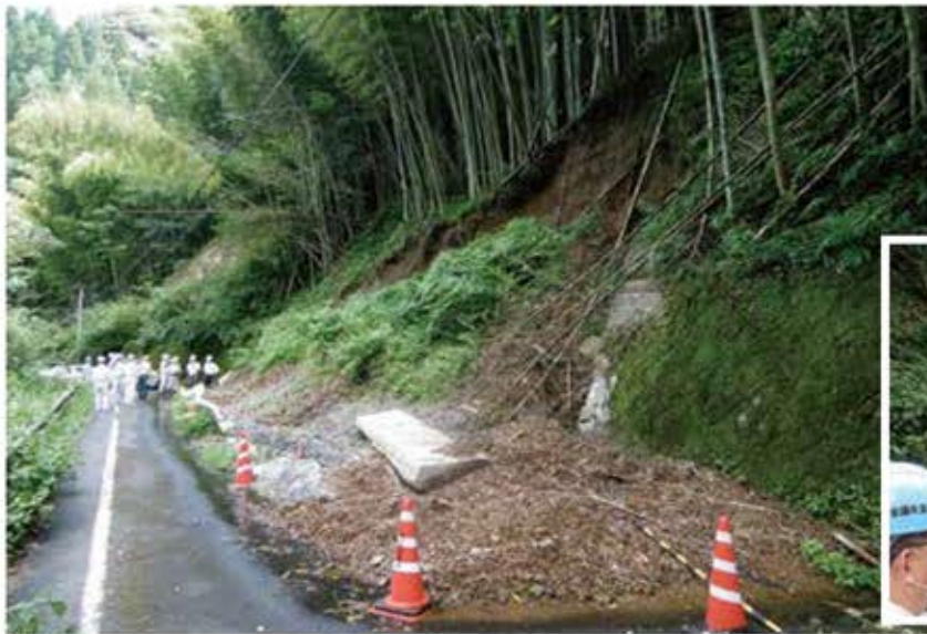
▲松生地区のがけ崩れ現場
