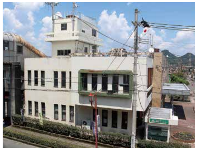
▲解体される本庁舎
