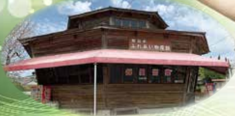
▲地質調査予定地であった「加治木物産館」
