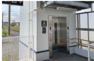
▲エレベーターが設置された加木木駅
