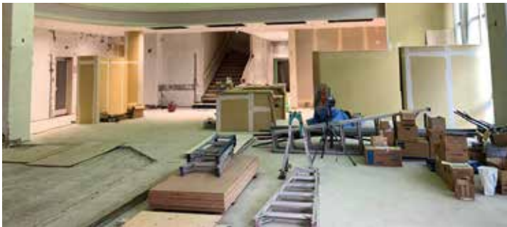
▲改修工事進行中の龍門滝温泉
