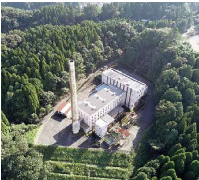
▲解体発注の吉田清掃センター
