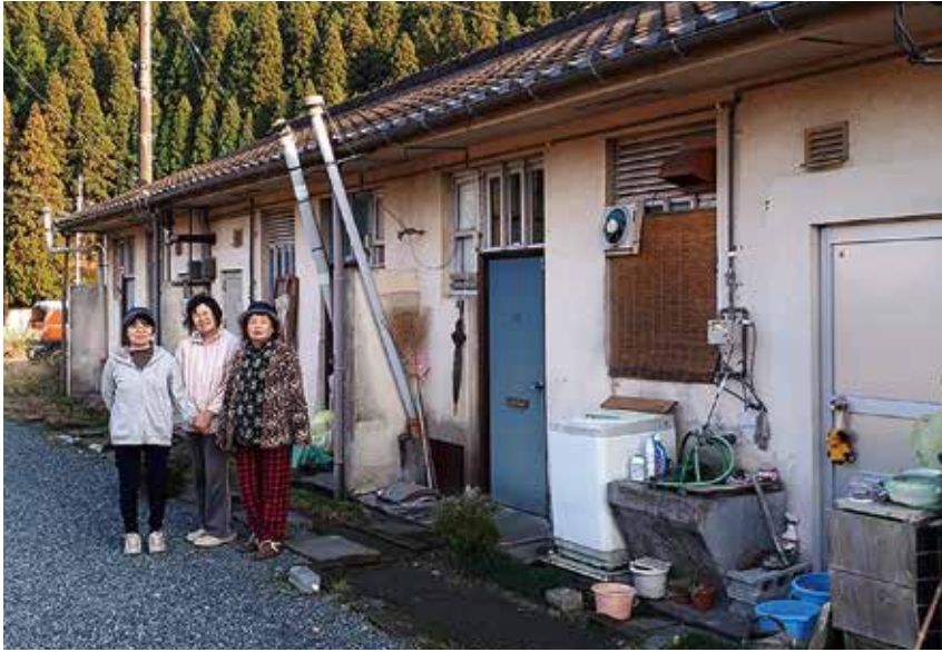
▲用途廃止になる高井田住宅
