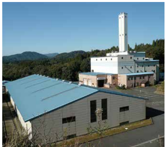
▲二酸化炭素の排出量削減に向けた施設整備
