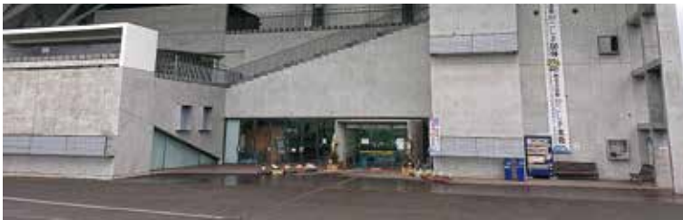
▲空調が設置される始良総合運動公園体育館
