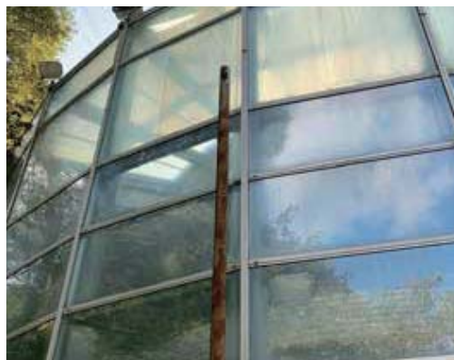
▲交換予定のカーテンウォールガラス
