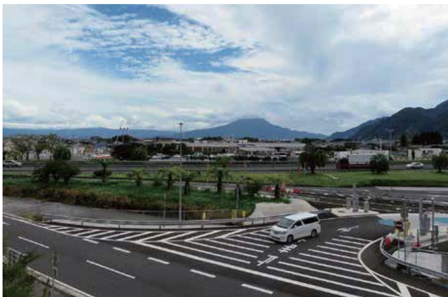
▲スマートインターチェンジで利便性が高まった始良市
