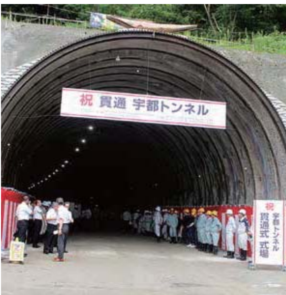
▲交通の利便性向上に期待が高まっている新宇都トンネル
