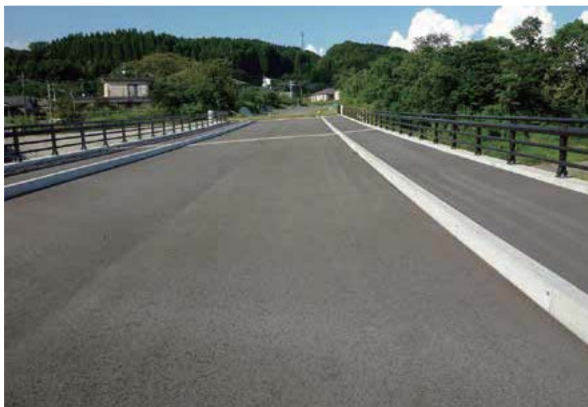
▲伊集院・蒲生・溝辺線の蒲生工区
