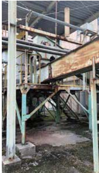
▲解体工事が始まる吉田清掃センター
