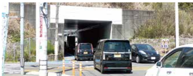
▲渋滞する市道トンネル
