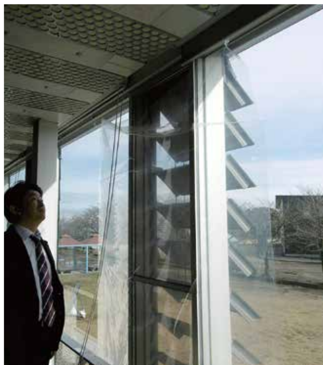
▲ジャロジーを調査する（総合体育館）
