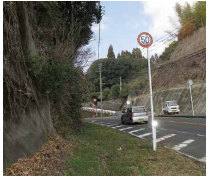
▲緒方自動車板金工場前の県道法面整備に期待
