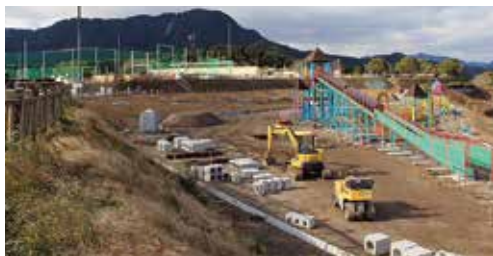
▲建設中の子ども広場と人工芝グラウンド
