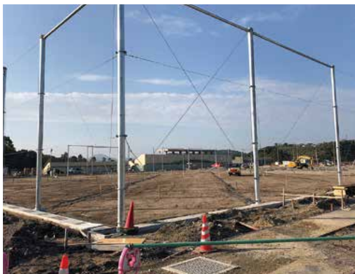
▲平成31年2月工事完了予定の人工芝グラウンド
