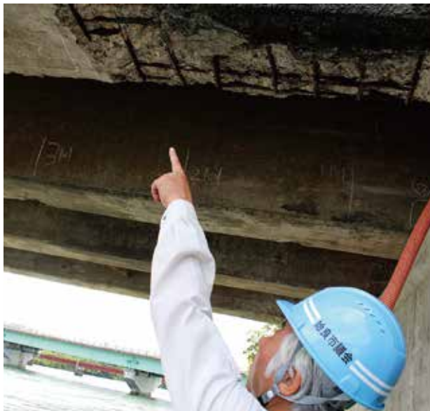
▲始良橋の現地調査を行いました
