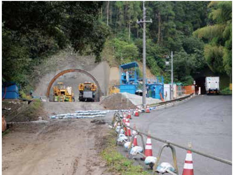
▲早期完成を目指し、工事が始まった宇都トンネル
