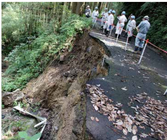
▲適切な対応で復旧工事が行われます（市道青敷線）
