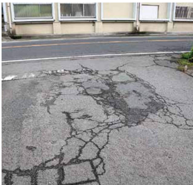
▲身近な道路の舗装補修が進みます
