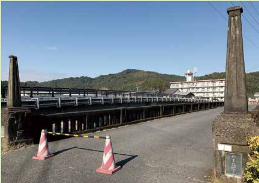
▲昭和4年に作られた山田橋
