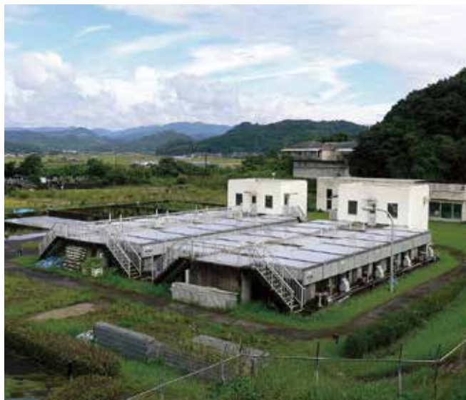
▲始良市の配水池
