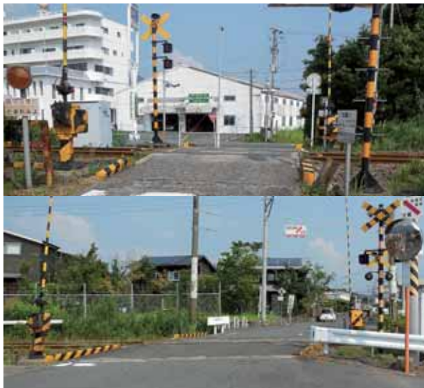
▲急げ！拡幅整備（上：山野踏切 下：地蔵橋踏切）
