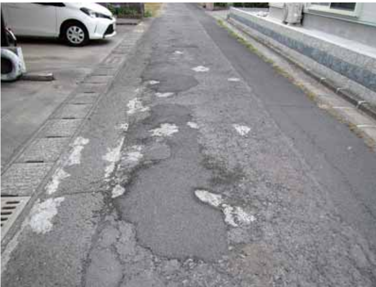
▲道路舗装補修を推進します
