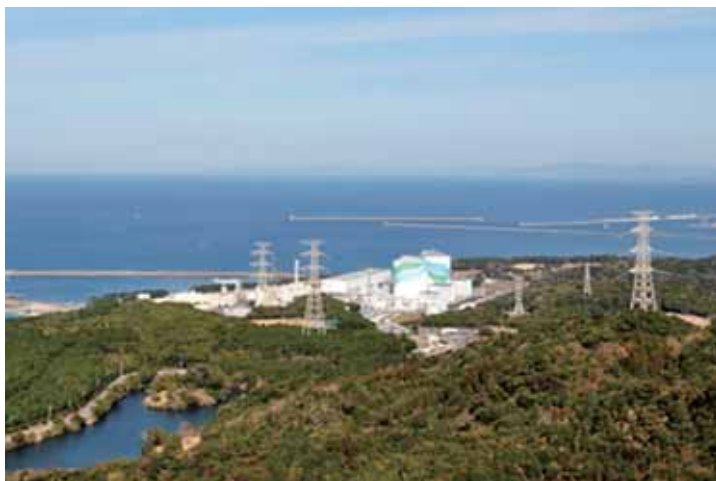
▲現在稼働中の川内原発
