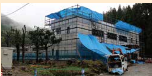
▲建設中の新工場
