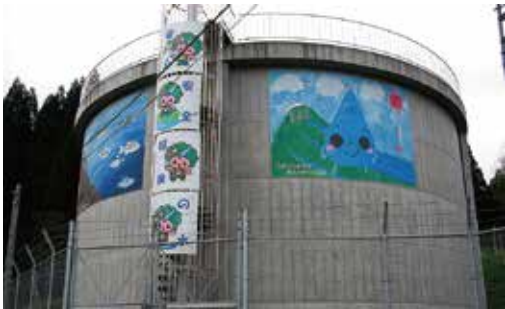
▲蒲生水道の配水池
