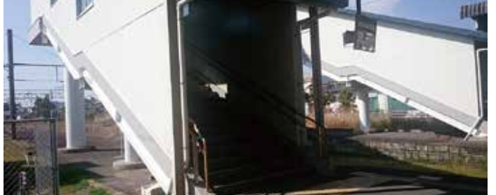
▲加治木駅にエレベーターが設置されます。
