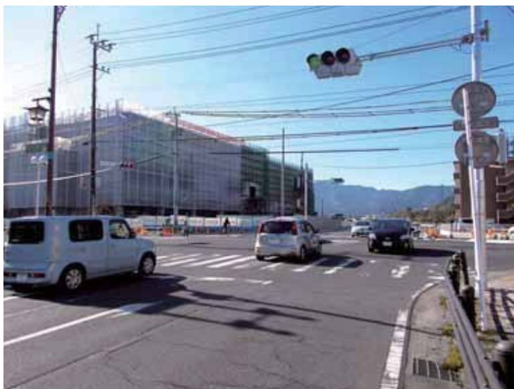
▲安全対策が望まれるイオン交差点付近
