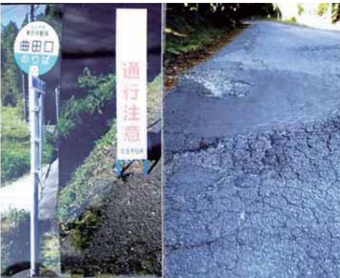
▲市道西別府線の現状
