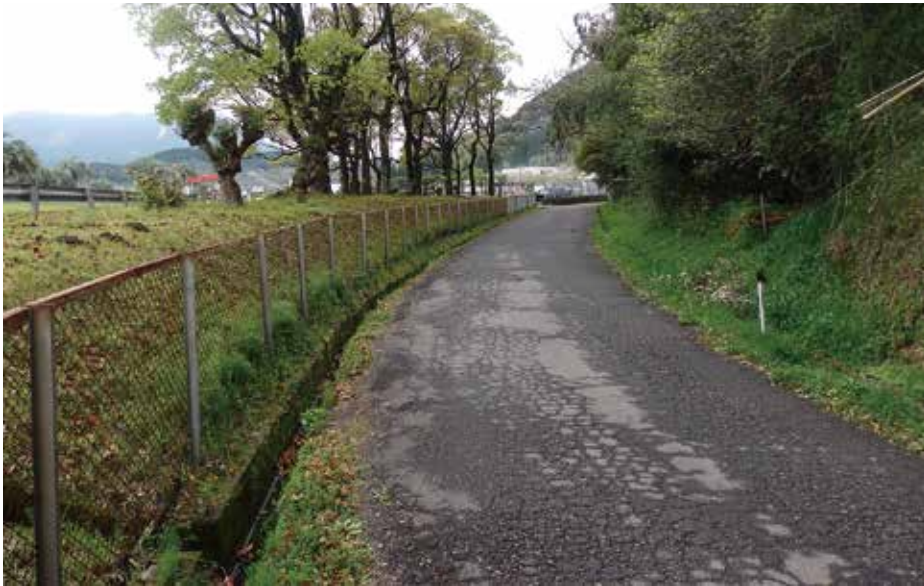
▲交通インフラ整備が進みます（サービスエリア線）
