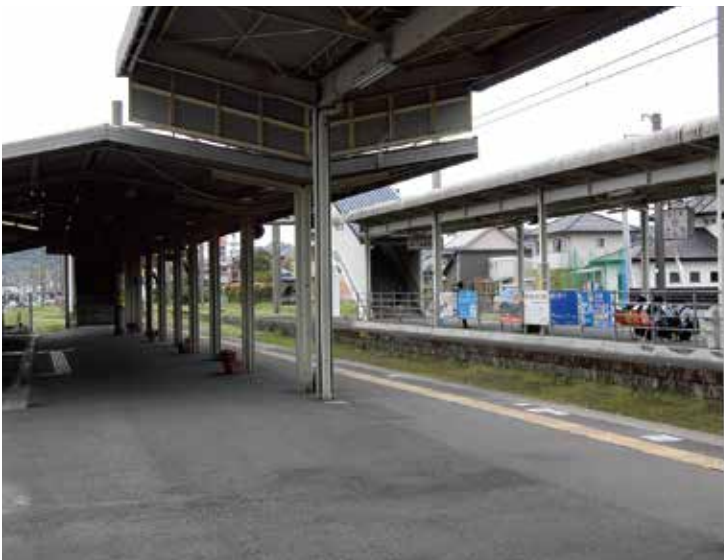
▲エレベーターが望まれる加治木駅ホーム
